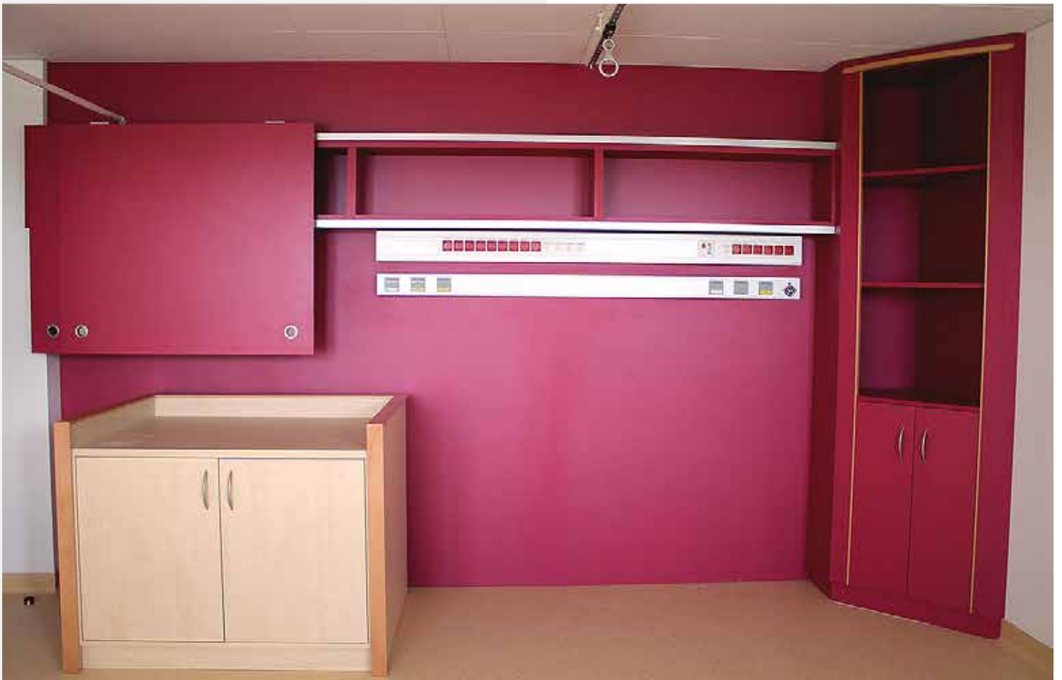
Équipements techniques muraux
